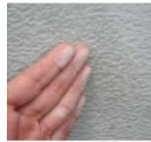
→ 外壁の塗料の膜が劣化して粉状になる現象。防水機能が低下してきています。塗替えを検討する時期
