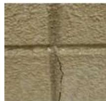
→ クラックの幅が0.3mm以上なら建物自体の劣化となります。放置することで雨漏り等を引きおこしてしまうので早めのメンテナンスが必要です。
