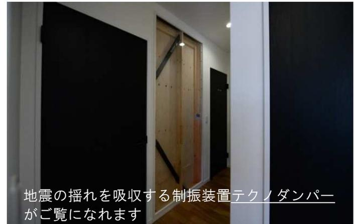
地震の揺れを吸収する制振装置テクノダンパー
